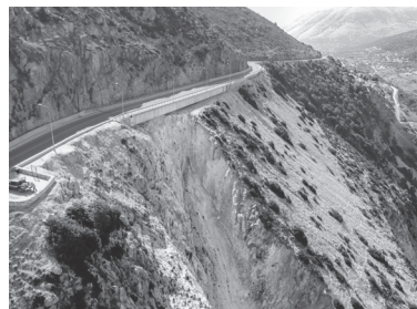
Εικόνα 28 Η νέα γέφυρα στην περιοχή του Χάρακα
